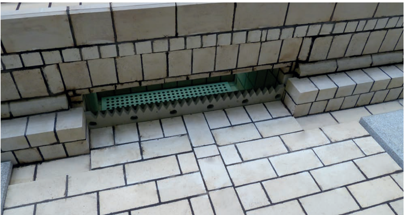
Ausmauerung mit CHEMOKITT FU 1310
