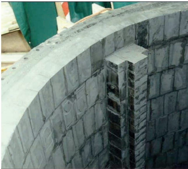
Aufbau der Ausmauerung
